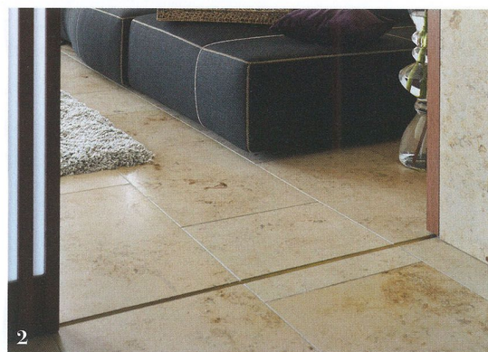
1. エントランスホール(CH2150mm)と奥のリビングとの間に千本格子の引き込み戸(W1150mm×H2150mm)を設置。建具枠を設けていないためすっきりとした印象をもたらし、格子の間に乳白色のポリカーボネート板を挟んでエントランスホールまで光が回り込むようにした。格子の幅と間隔を25mmにそろえて小間返しに。左側がゲストルームを兼ねた和室 2. 空間の一体感を損なわないよう、ジュラストーン貼りの床に真鍮製のVレールを埋め込んでフラットな床を実現。右手には千本格子の収納扉があり、その戸尻が引き込み戸の戸当たりを兼ねている
